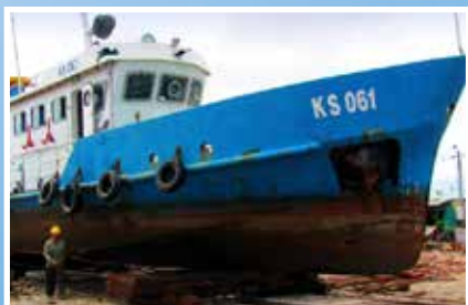
Sửa chữa các phương tiện thủy
