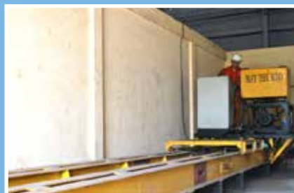
Kiểm định thiết bị công nghiệp
