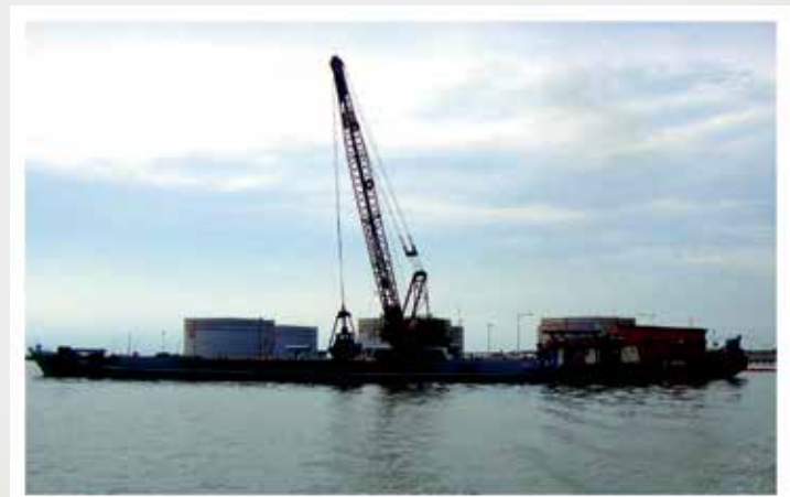
Nạo vét công trình cảng PVIOL - VT
