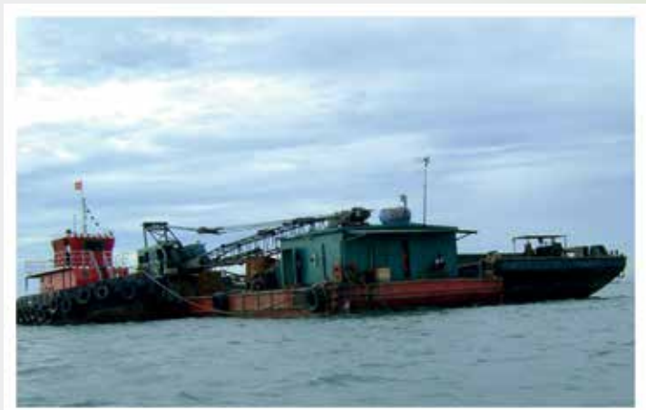
Nạo vét công trình luồng Thị Vải - Cái Mép
